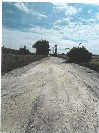
Prístupová zaužívaná komunikácia
