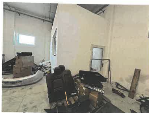
Sklad súp.č. 224 – vstavba kancelárie
